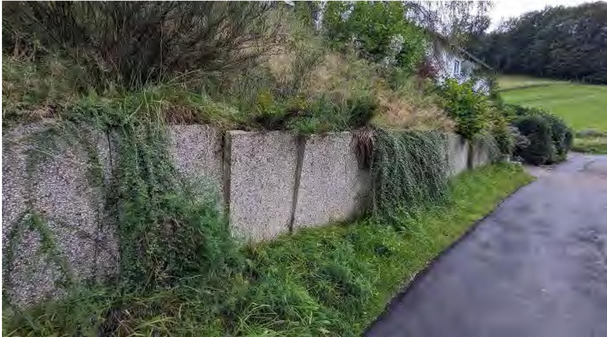
**Fotodokument 13 – Winkelsteine zur Straße "Am Löh" dienen zur Abfangung der Böschung. Die Standsicherheit der Winkelsteine und des Erdreiches kann nach Einschätzung des Unterzeichners nicht sichergestellt werden.**
