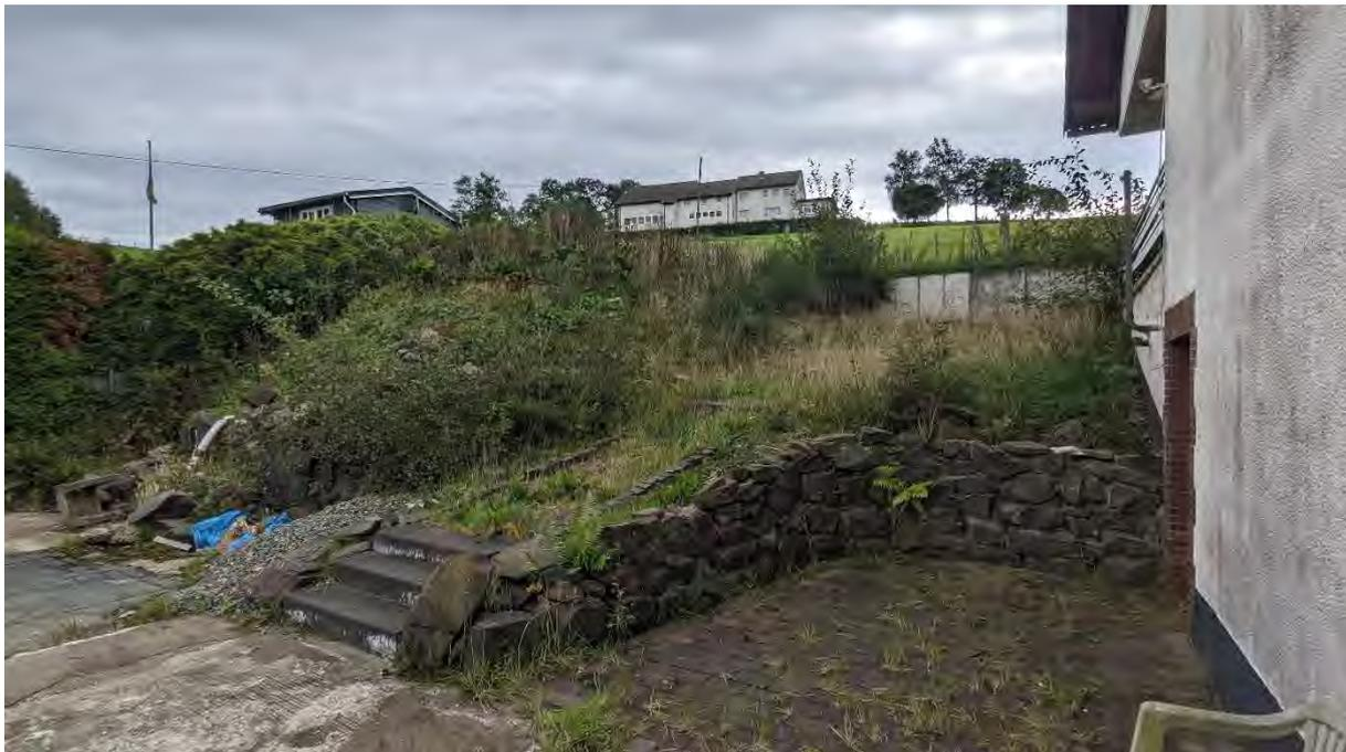
**Fotodokument 12 – nordöstliche Grundstücksfläche. Im Vordergrund der Zugang zum Untergeschoss mit Pflastersteinfläche und Natursteinböschung, einzelnen Betonstufen. Die Zuwegung zum Eingang des Erdgeschosses fehlt.**
