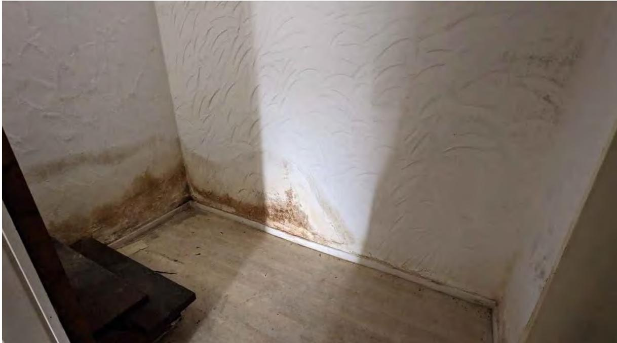
Fotodokument 17 – Wohnhaus – UG – Raum "Flur" im Bereich der Treppe mit Durchfeuchtung der Außenwand und Zwischenwand zum Raum "Heizung"
