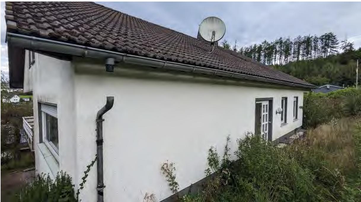
**Fotodokument 6 – Wohnhaus – KG – Ansicht von Süden mit defektem Fallrohr der Dachrinne**
