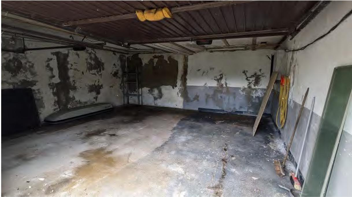
**Fotodokument 11 – Doppelgarage – Innenansicht mit Feuchtigkeitsschäden an den Umfassungswänden**
