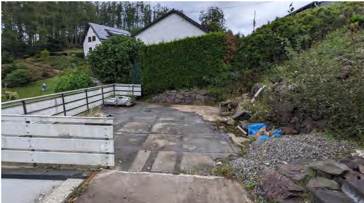
**Fotodokument 10 – Doppelgarage – Dach von Süden mit freigelegter und defekter Horizontalabdichtung**
