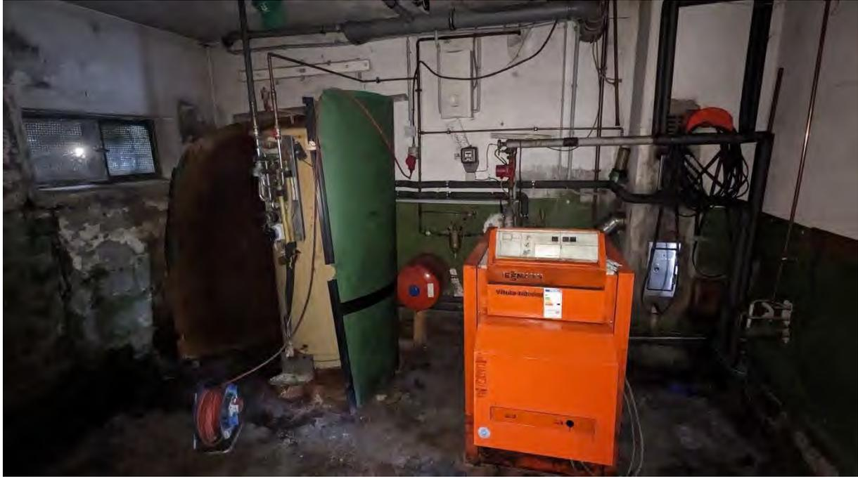
Fotodokument 15 – Wohnhaus – UG – Raum "Heizung" mit Öl-Gebläsebrenner (unterliegt der Austauschpflicht gem. GEG) und Warmwasserspeicher (defekt)
