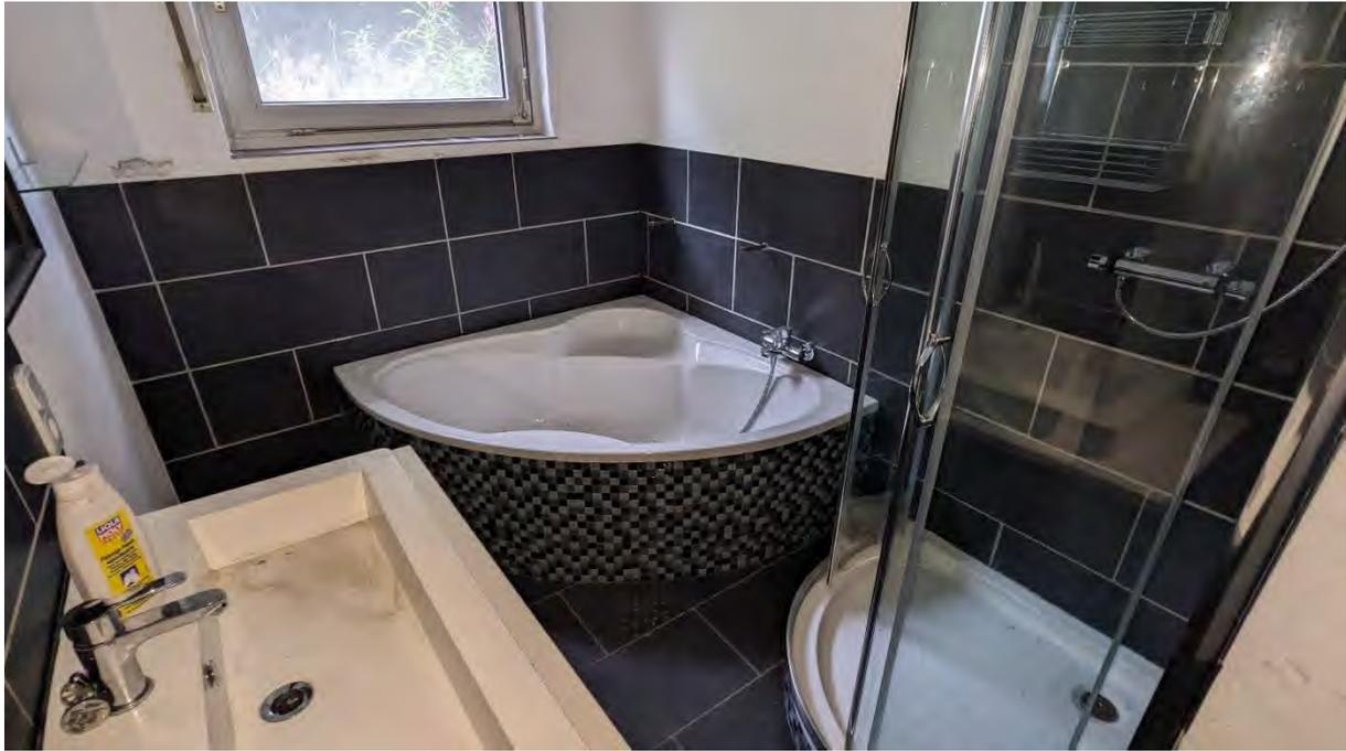
**Fotodokument 23 – Wohnhaus – UG – Raum "Bad / WC mit Eckbadewanne" und Dusche (Die Duschtasse biegt sich bei Belastung.) Die dauerelastische Fuge zwischen Wand und Duschtasse ist abgerissen und undicht.**
