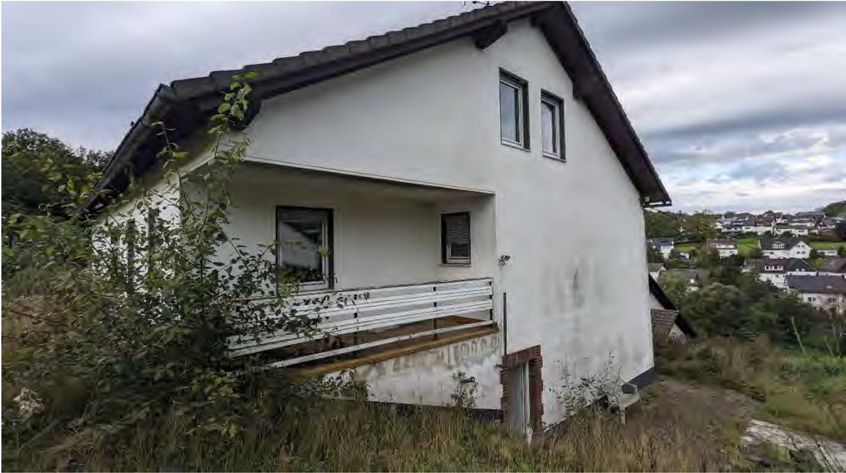
**Fotodokument 5 – Wohnhaus – Ansicht von Nordosten mit Balkon vor dem Kinderzimmer (zu erkennen ist der Feuchtigkeitsschaden unterhalb der Spaltklinkerabdichtung des Balkons - Farbabplatzungen)**
