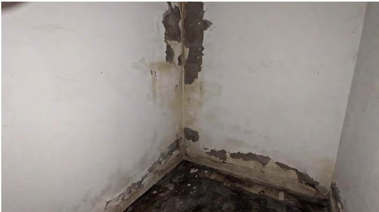
**Fotodokument 20 – Wohnhaus – UG – Raum "Keller" mit Feuchtigkeitsschäden in den Außenwänden (südliche Gebäudeecke). Auf der Außenseite befindet sich auch das nicht angeschlossene Dachrinnenfallrohr.**
