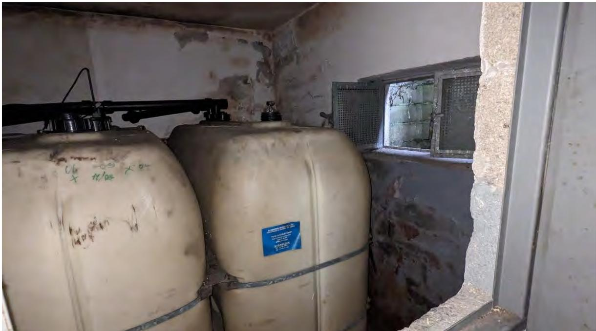
Fotodokument 16 – Wohnhaus – UG – Raum "Öllager" mit Durchfeuchtungen der Außenwände
