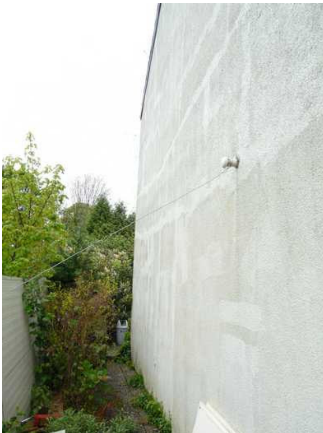
Teilansicht von Südosten
