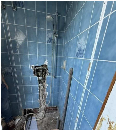
Bild 19: Bad DG im Rohbau
