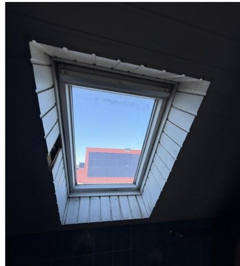
Bild 20: älteres Dachflächenfenster DG
