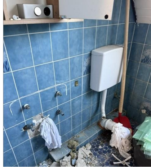
Bild 18: Bad DG im Rohbau
