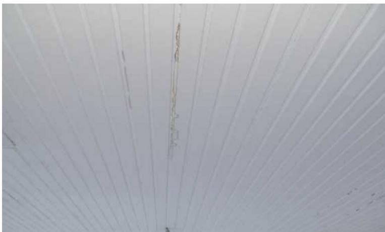
B27 Zustand der Deckenverkleidung im Wohnzimmer, keine weitere Angabe möglich – vermutlich Undichtigkeit am Dachaufbau
