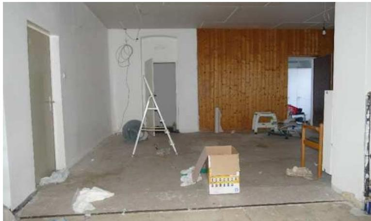
B4 Zustand des Innenausbaus im Ladenlokal: Deckenverkleidung, Bodenbeläge und Elektroarbeiten tlw. nicht fertiggestellt
