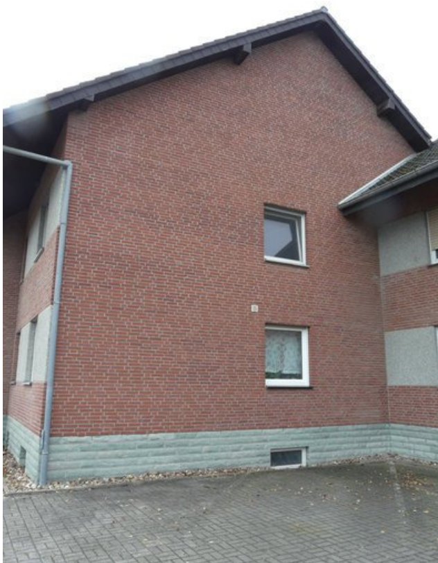
Ansicht von Norden (Haus I)
