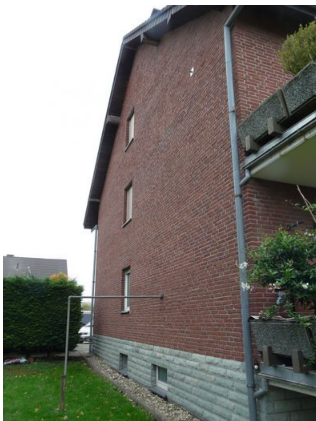
Ansicht von Nordwesten (Haus II)
