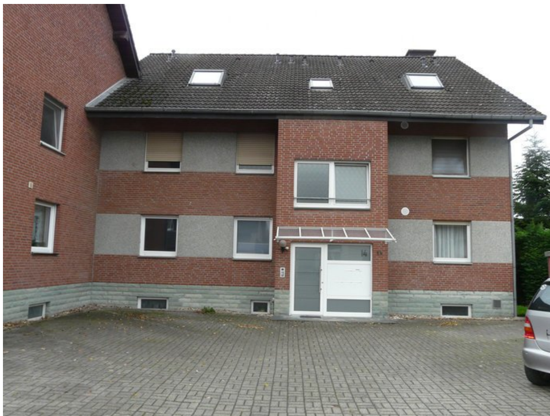
Teilansicht von Osten (Haus II)
