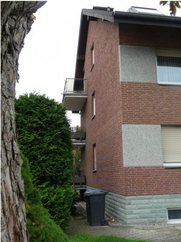
Ansicht von Südosten (Haus I)
