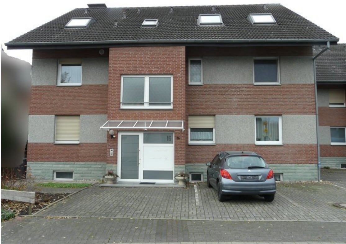
Teilansicht von Osten (Haus I)
