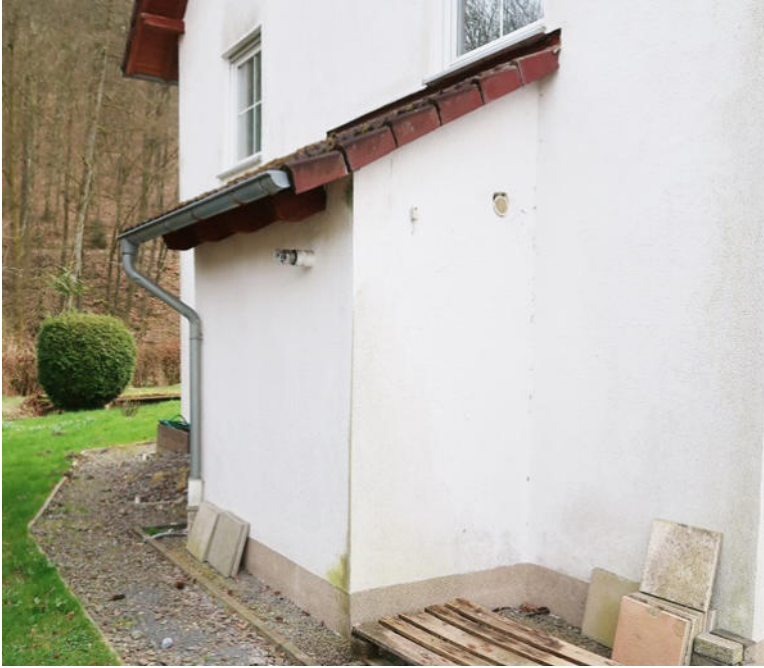
Auskragender Teil des Abstellraums im EG – rechts die Öffnung für die Frischluftzufuhr, links das aus der Außenwand ragende Abgasrohr.
