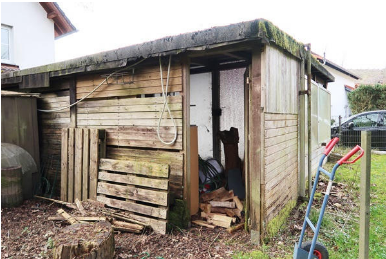
Holzlager hinter dem Carport
