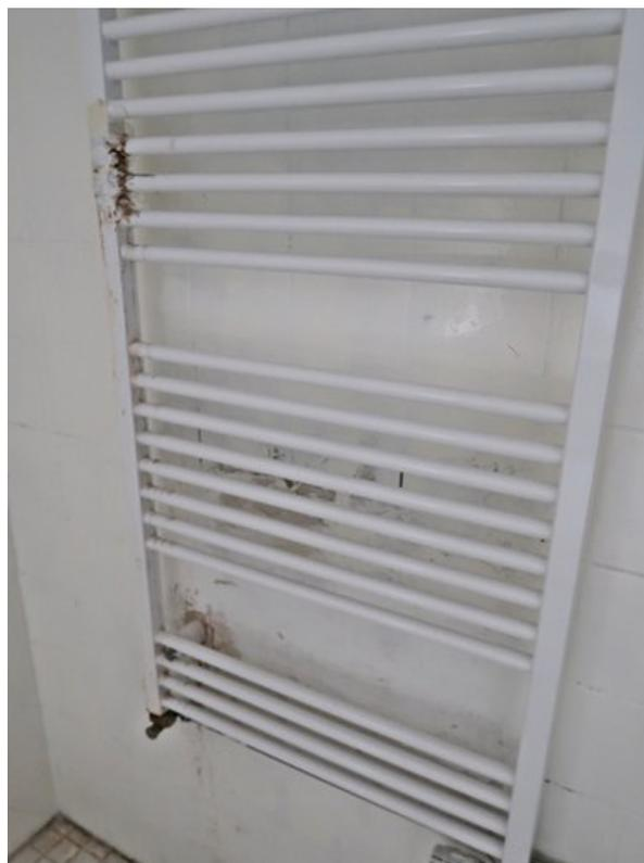
Putzschäden und Schäden am Heizkörper Bad
