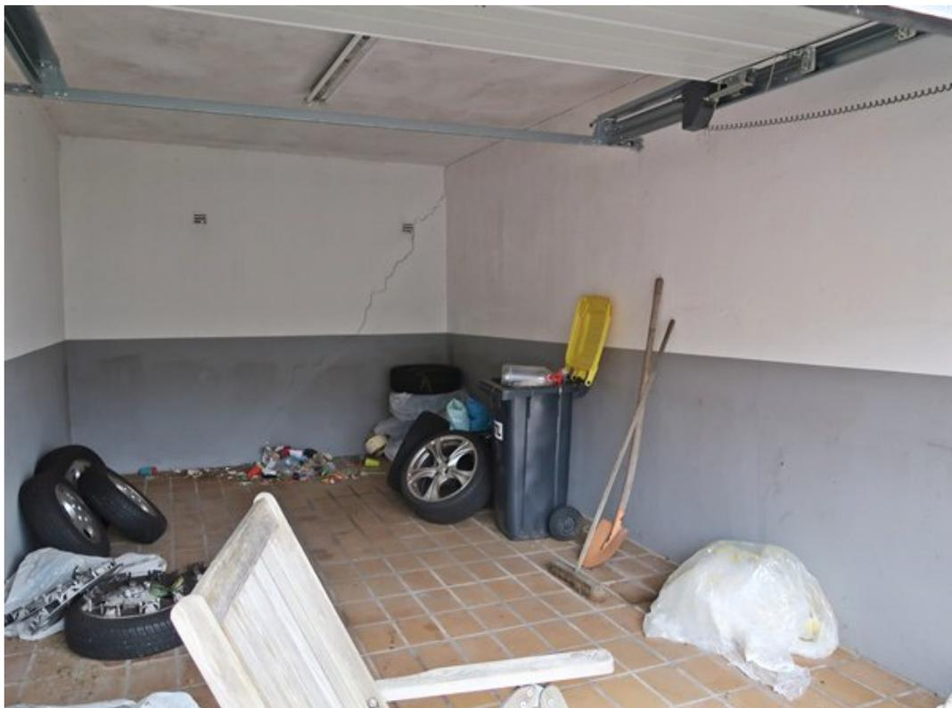
Garage mit Risschaden an der Rückwand
