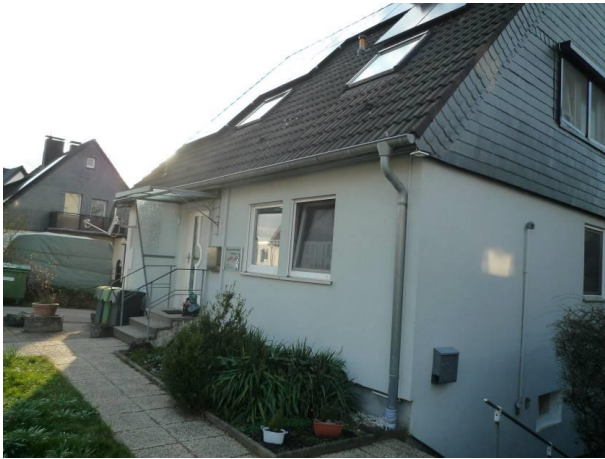
1) Blick auf Einfamilienhaus mit Einlieger Wohnung Straßenansicht mit Nordostgiebel
