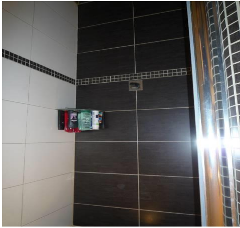
7) Blick auf Duschbad EG mit Bodentiefer Dusche
