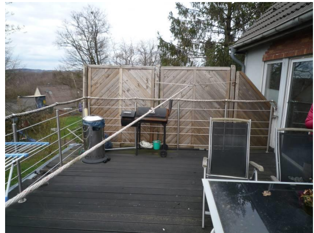
4) Balkon über I- gesch. Anbau zur Nordwestseite
