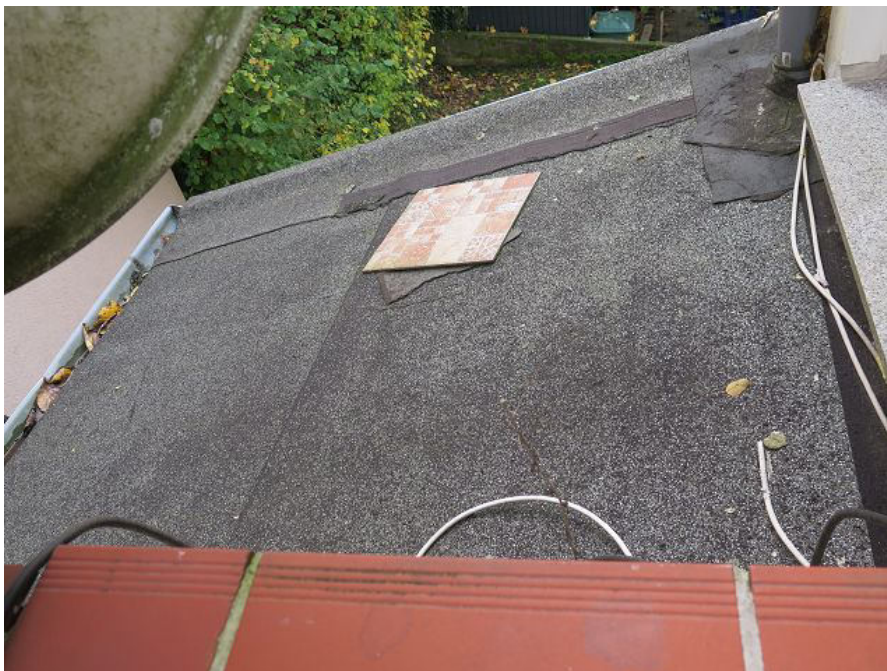
30) Dachfläche über der Treppe zum Obergeschoss
