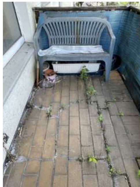
Bild 20: Richterskamp 2 – Wohnung 2. OG vorn – Balkon
