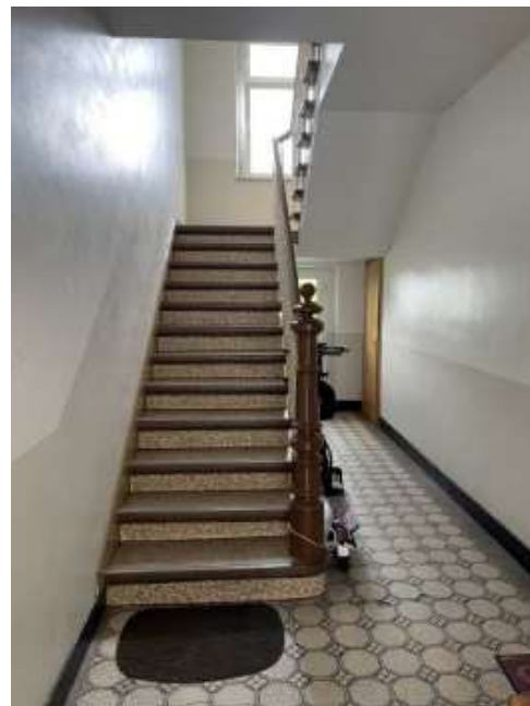
Bild 24: Nordstraße 15 – EG – Treppenhaus
