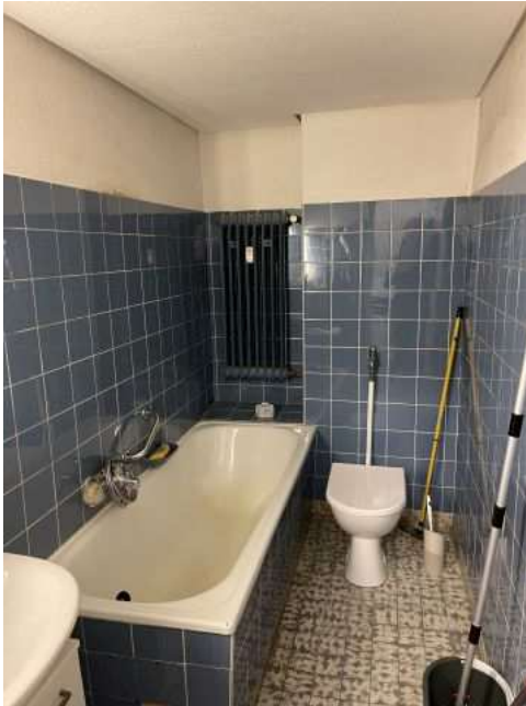
Bild 17: Richterskamp 2 – Wohnung 1. OG hinten – Bad
