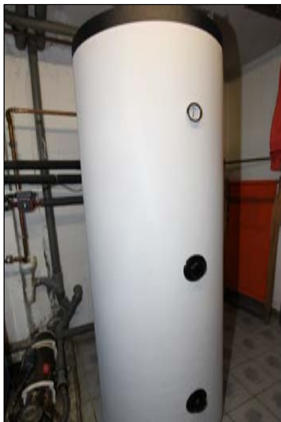
Warmwasserpufferspeicher
