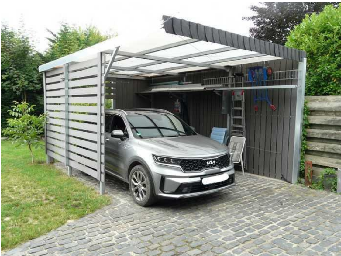
Ansicht von Nordosten (Carport)
