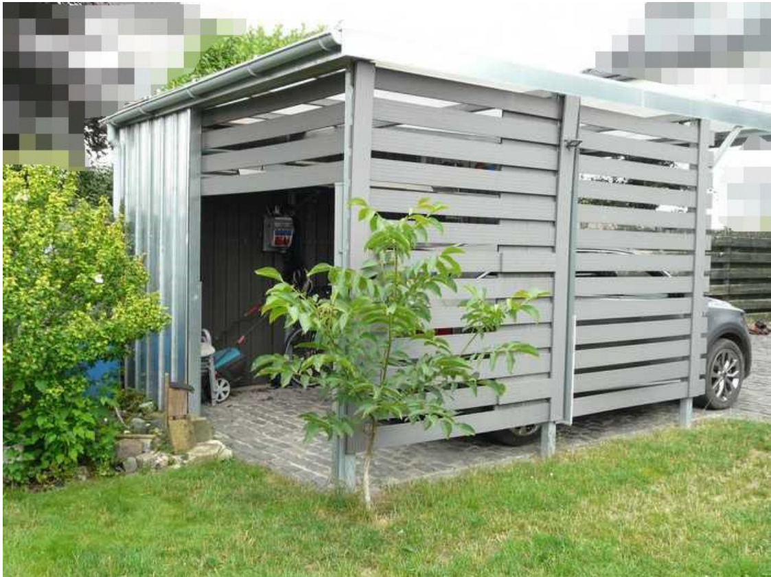
Ansicht von Südosten (Carport)
