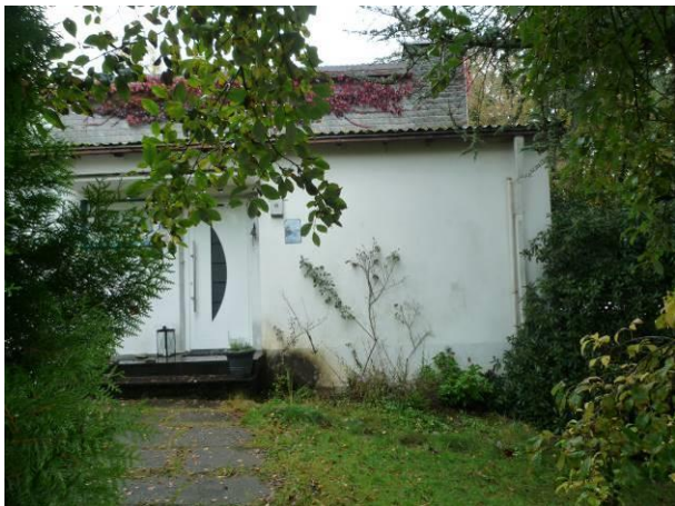
1) Blick auf Bewertungsobjekt Straßenansicht mit Blick zum Hauseingang
