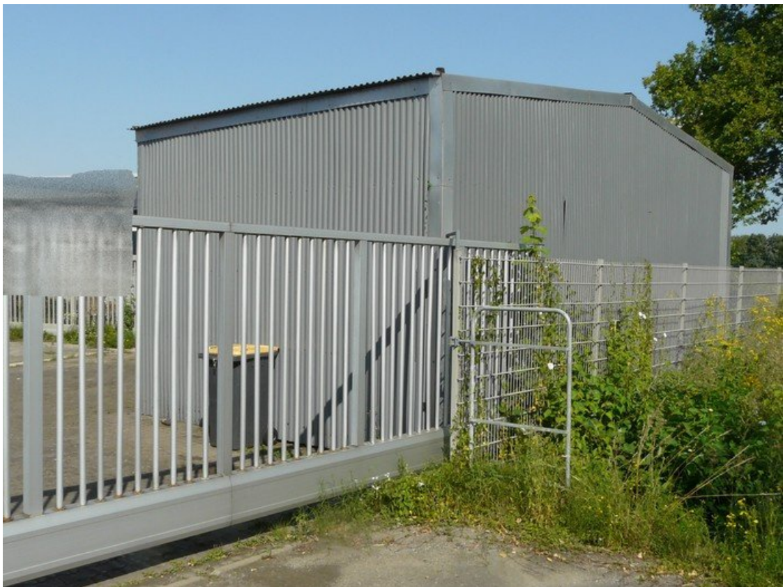
Ansicht von Südosten
