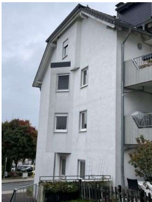
Bild 7: Rückansicht von rechts des Gebäu- deteils Hsnr. 38
