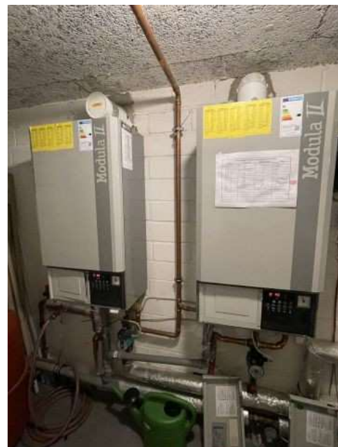
Bild 20: KG - Gas-Wandheizkessel
