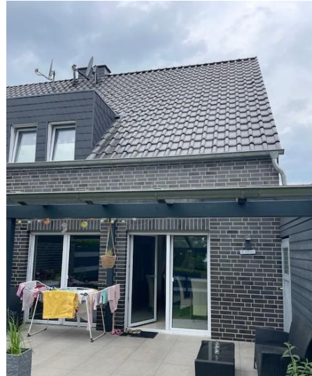
Bild 2: Ansicht aus südöstlicher Richtung
