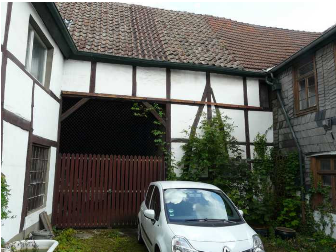
Nicolaiweg 1 a: Ansicht von Süden (Zwischentrakt)
