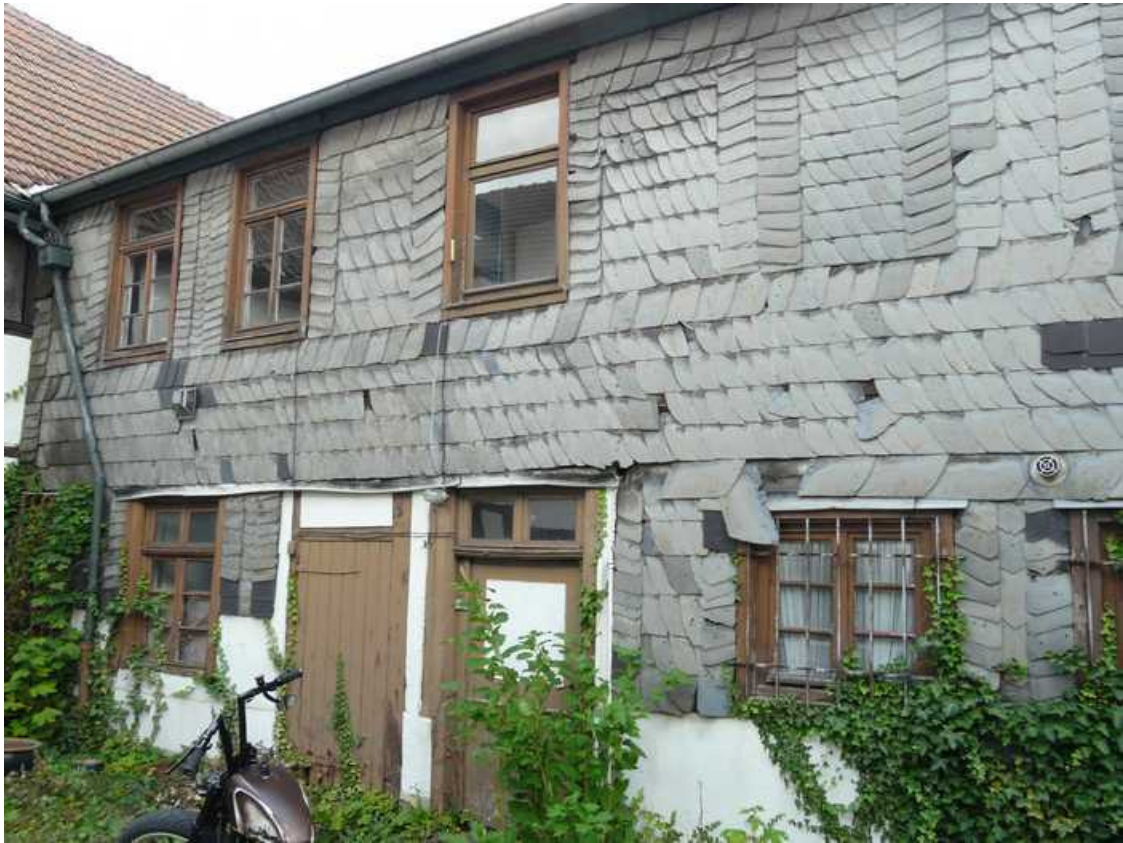
Cappelstr. 74: Ansicht von Südwesten
