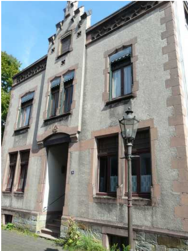
Nicolaiweg 1 b: Ansicht von Süden
