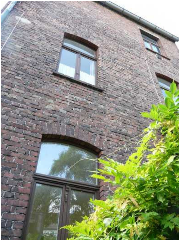
Nicolaiweg 1 b: Teilansicht von Norden
