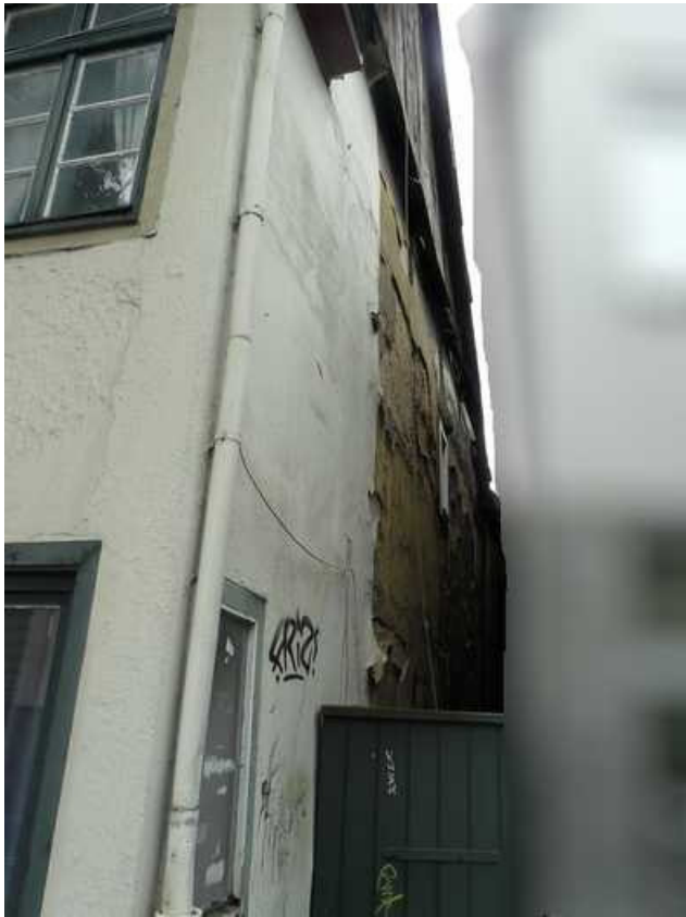
Cappelstr. 74: Teilansicht von Nordosten
