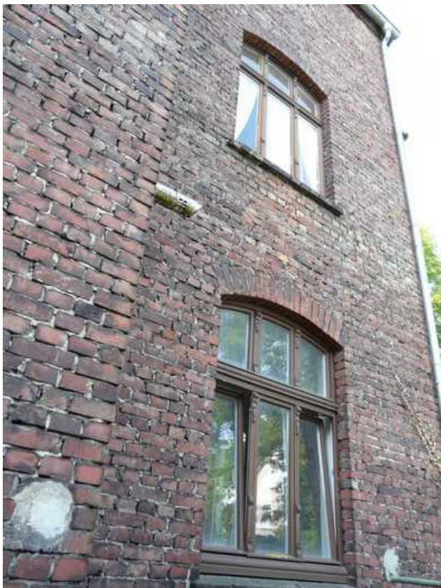
Nicolaiweg 1 b: Teilansicht von Norden
