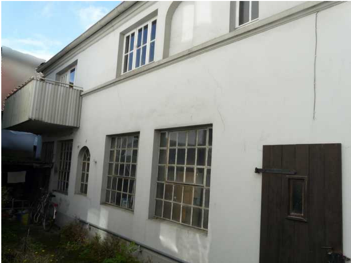
Nicolaiweg 1 a: Teilansicht von Südwesten
