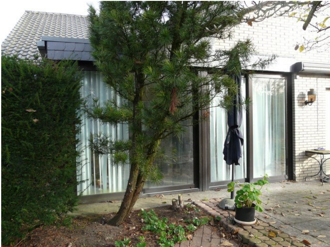
Teilansicht von Südwesten
