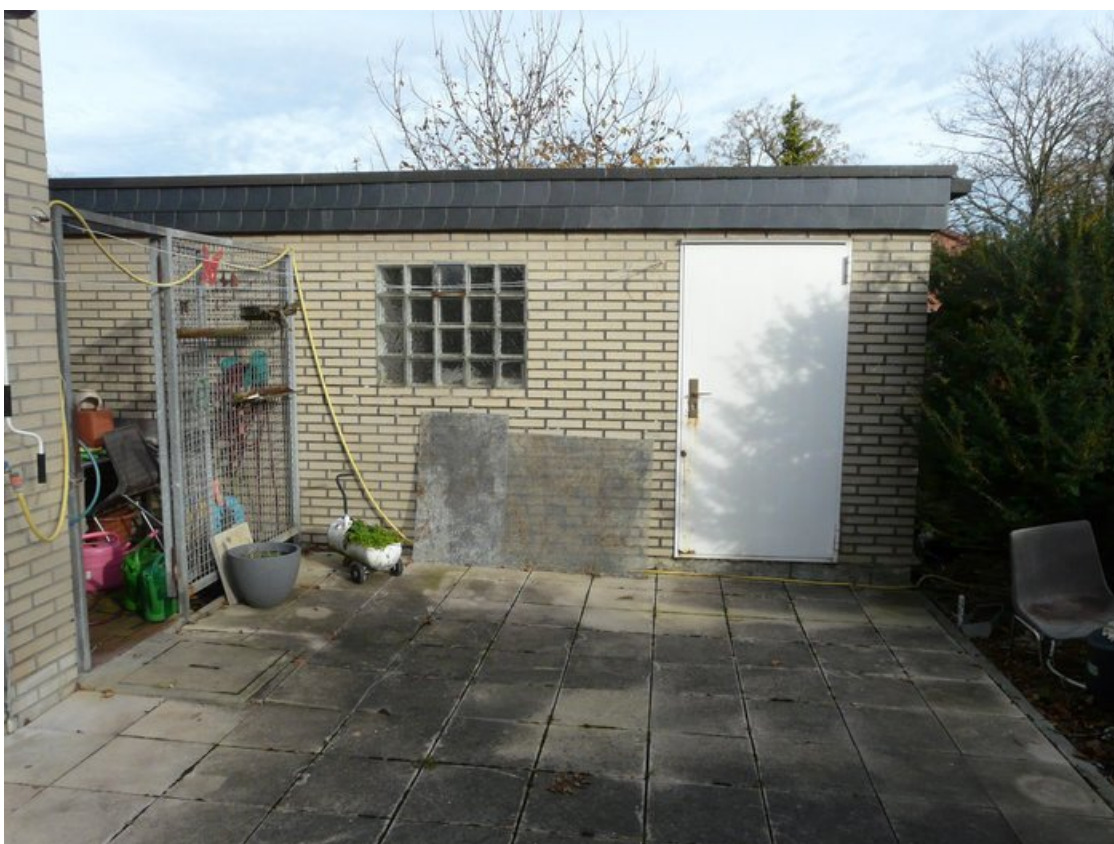
Ansicht von Südwesten (Doppelgarage)
