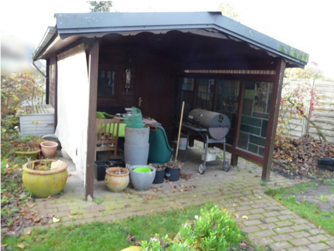
Ansicht von Nordosten (südl. Gartenhaus)
