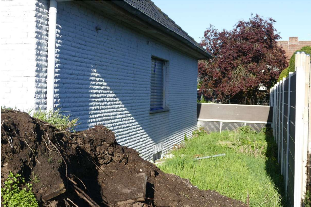
G3 | Ansicht der nordöstlichen Fassade
