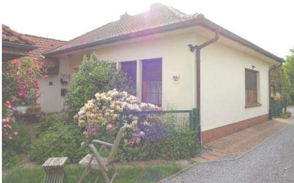
Foto Nr. 2 – Gebäuderückansicht
