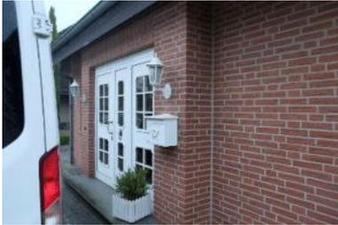
Wegen einer Eingangsstufe zum Hauseingangsbereich, ist der Zugang zum Gebäude nicht barrierefrei, kann ggf. aber mit einer Rampe nachgerüstet werden.
