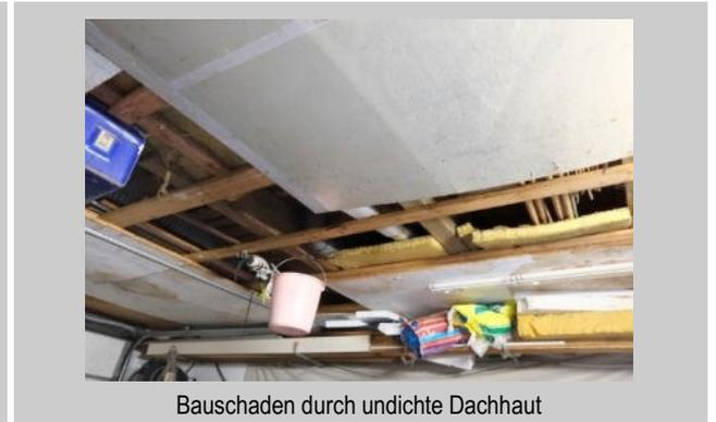
Bauschaden durch undichte Dachhaut
