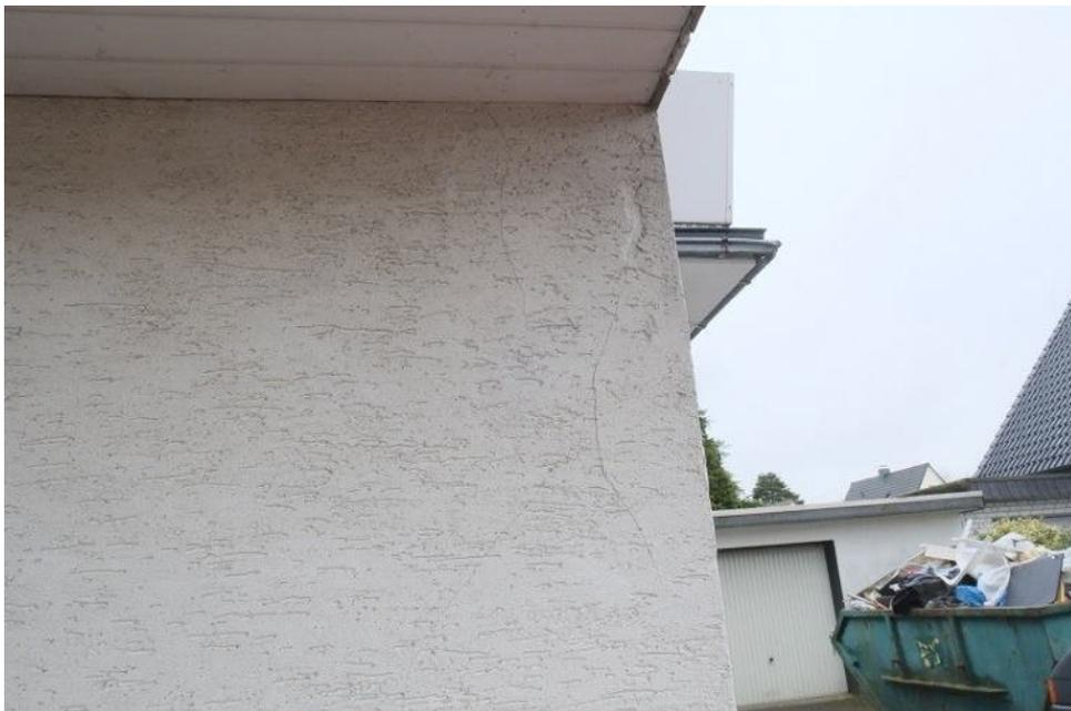
Bild 8: Blick auf die Fassade (mit Schaden am Außenputz)
