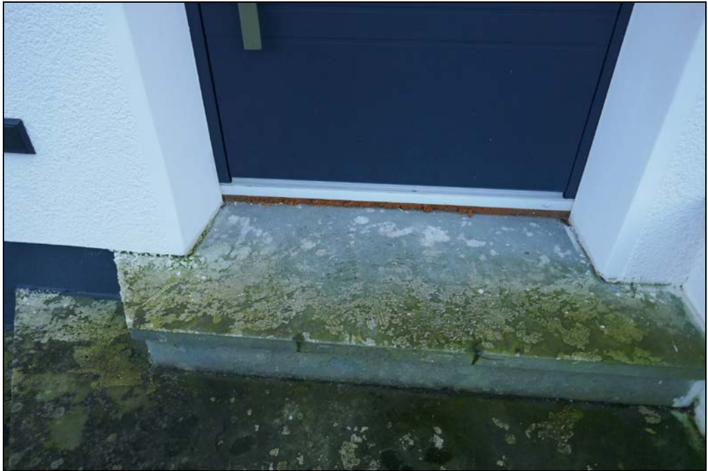
Anschluss Haustür – nicht ordnungsgemäß fertiggestellt
