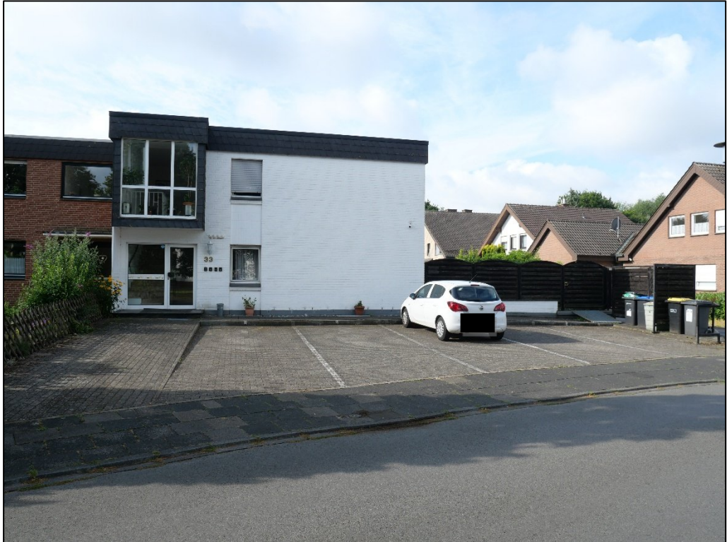
Straßenansicht mit Stellplätzen
