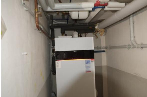
Bild 27: Zentrale Gasheizung
