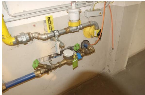
Bild 26: Gas- und Wasserhausanschluss
