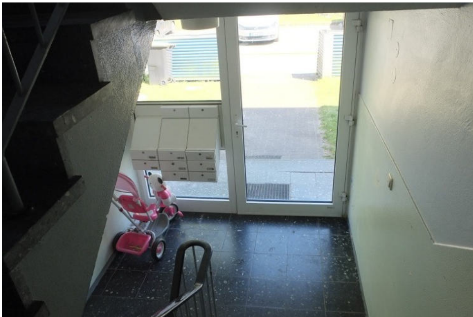
Bild 4: Treppenhaus im Hauseingangsbereich
