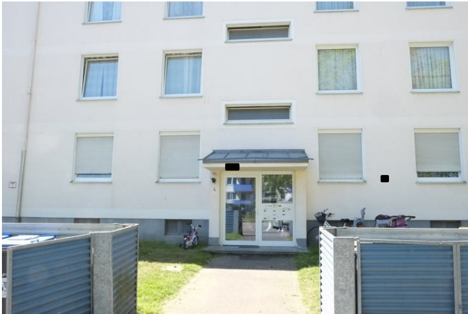
Bild 3: Blick auf den Hauseingangsbereich
