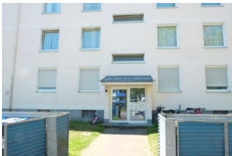
Außenanlagen des Vorgartens mit Müllboxen
