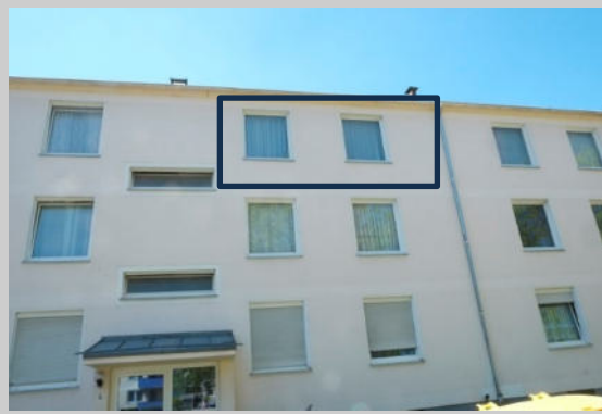
Wohnung Nr. 5 im 2. Obergeschoss rechts
