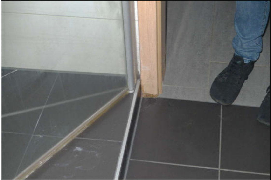
Abbildung 37 beidseitig Feuchteschäden an der Türzarge der Badezimmertür in der Wohnung im Dachgeschoss fotografiert am 26.03.2025
