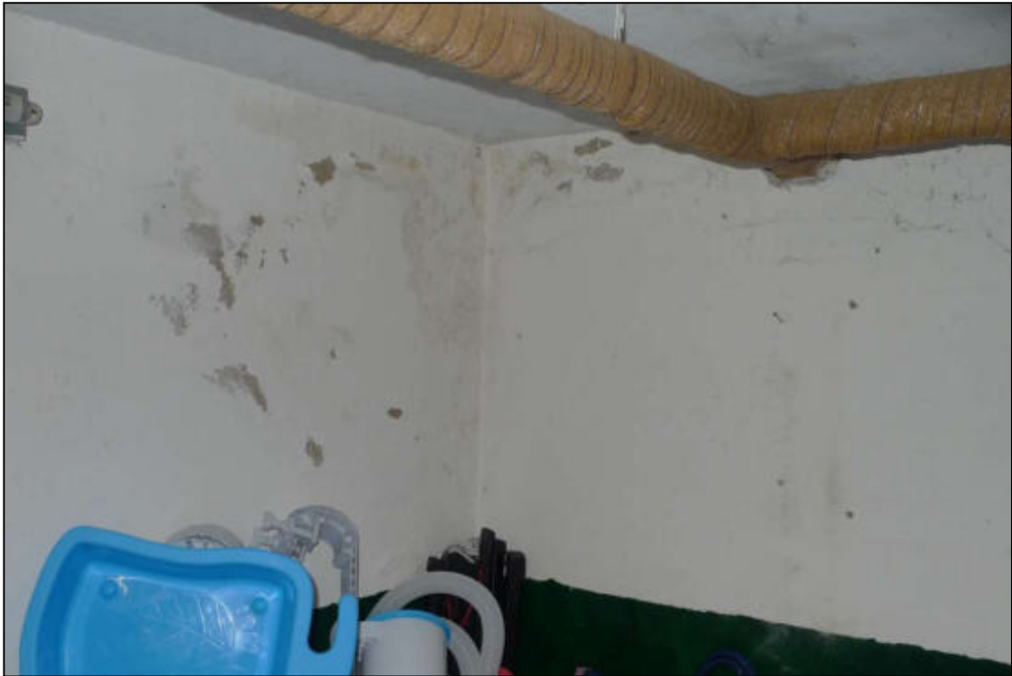
Abbildung 35 leichte Feuchtigkeitserscheinungen an der Kelleraußenwand fotografiert am 26.03.2025
