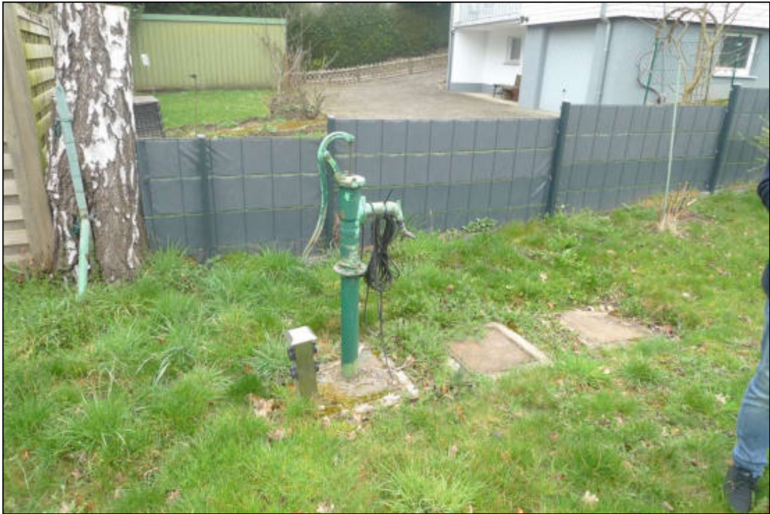
Abbildung 46 Schacht mit Schwengelpumpe im Garten fotografiert am 26.03.2025
