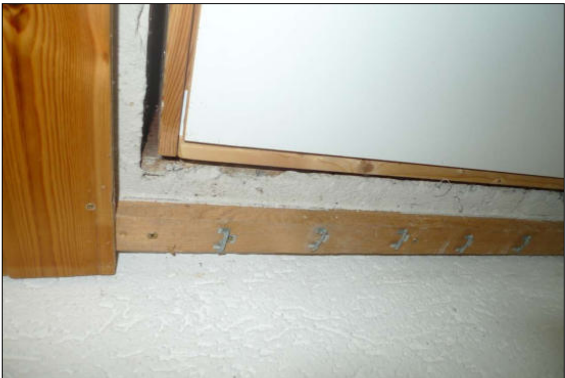
Abbildung 36 defekter Zugang zum Spitzboden fotografiert am 26.03.2025
