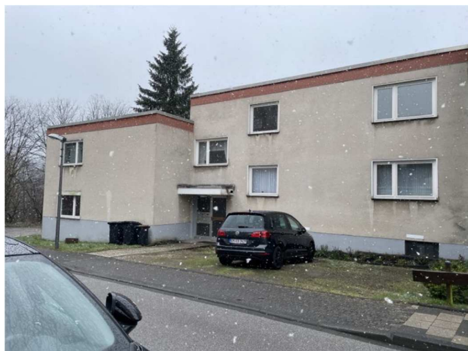
Mehrfamilienhaus Siedlungsweg 1 - Ansicht vom Siedlungsweg
