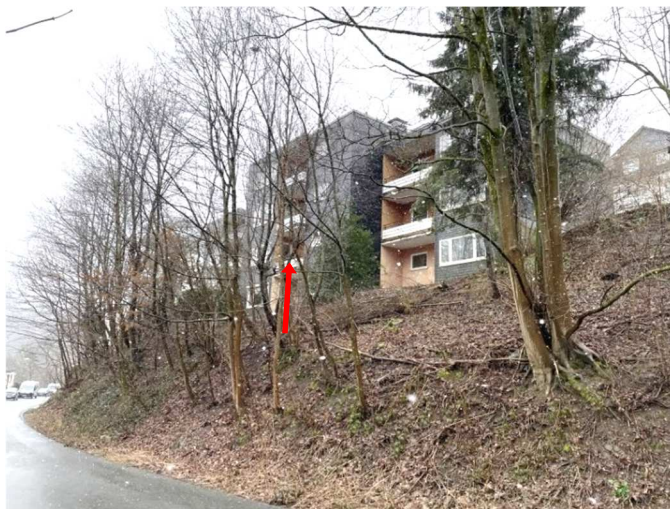
Mehrfamilienhaus Siedlungsweg 1 - Ansicht vom Schröderweg
