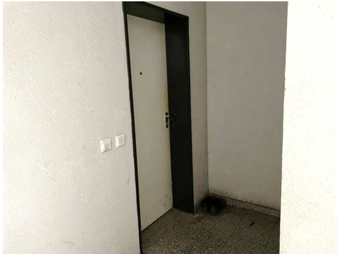
Eingangstür Wohnung Nr. 3 im 1. Untergeschoss rechts
