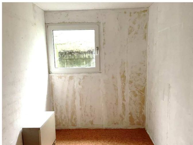
Wohnung Nr. 2: Kellerraum
