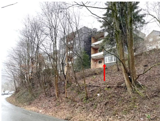
Mehrfamilienhaus Siedlungsweg 3 - Ansicht vom Schröderweg
