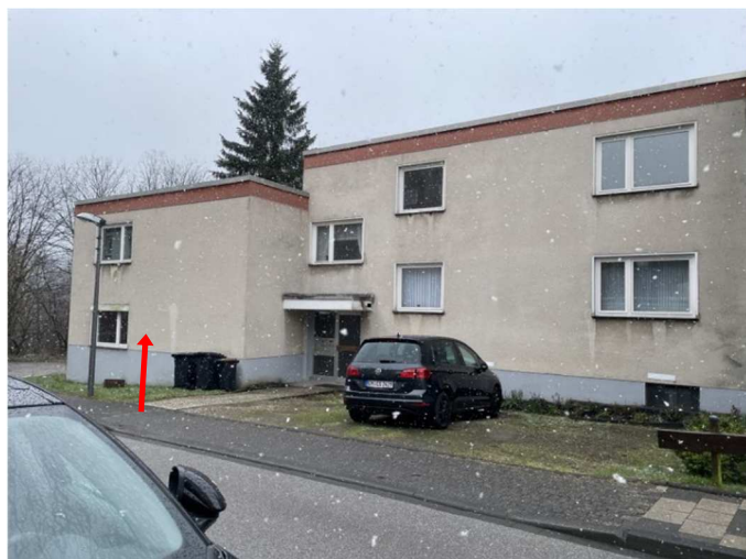
Mehrfamilienhaus Siedlungsweg 3 - Ansicht vom Siedlungsweg
