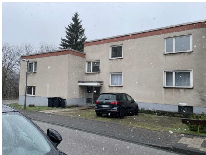
Mehrfamilienhaus Siedlungsweg 1 - Ansicht vom Siedlungsweg
