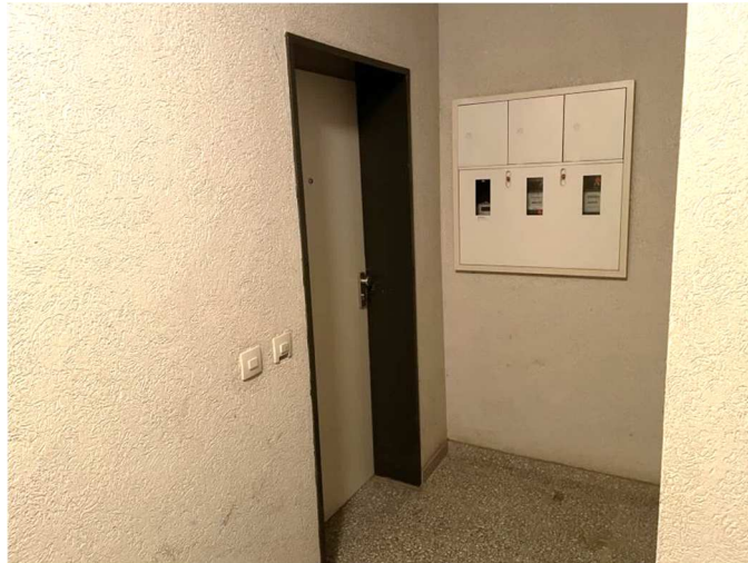
Eingangstür Wohnung Nr. 1 im 2. Untergeschoss rechts
