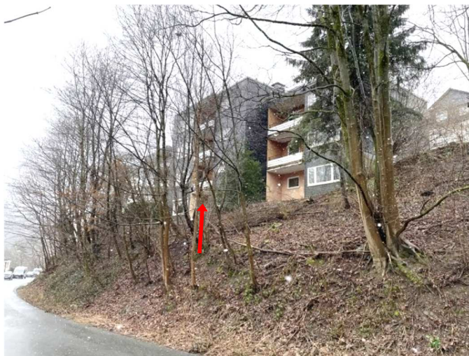
Mehrfamilienhaus Siedlungsweg 1 - Ansicht vom Schröderweg
