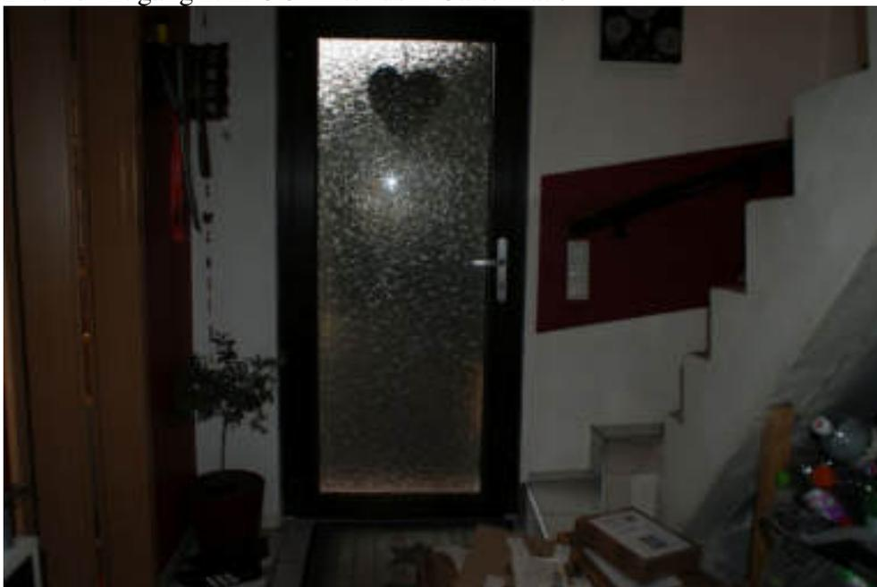
Bild 18 Diele UG / Einfachverglaste Alu-Eingangstür
