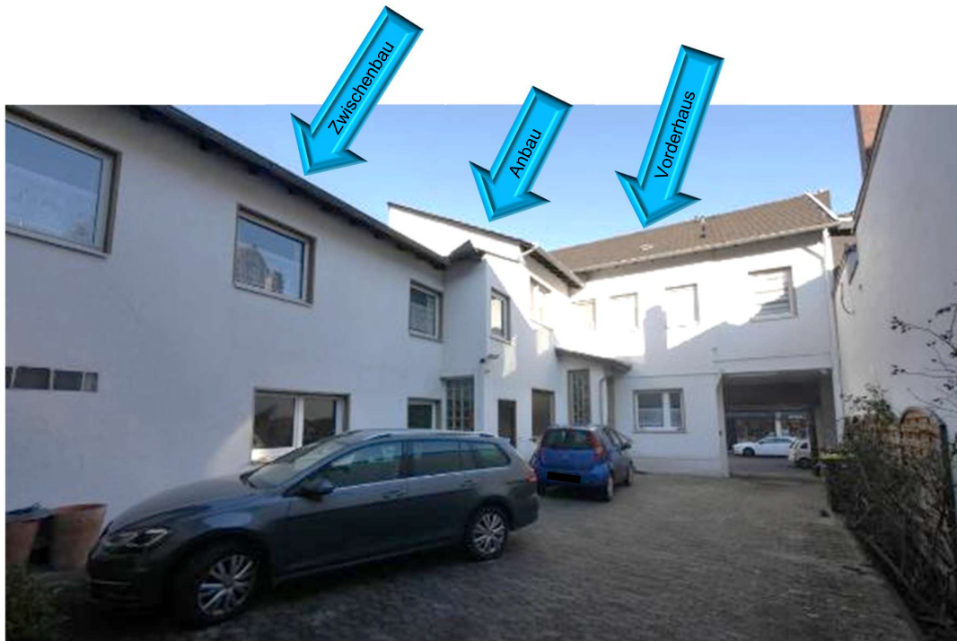
Bild B6 Hofansicht Zwischenbau mit Anbau und Vorderhaus
