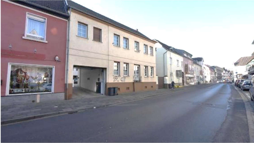
Bild A1 Blick in die Erschließungsstraße
