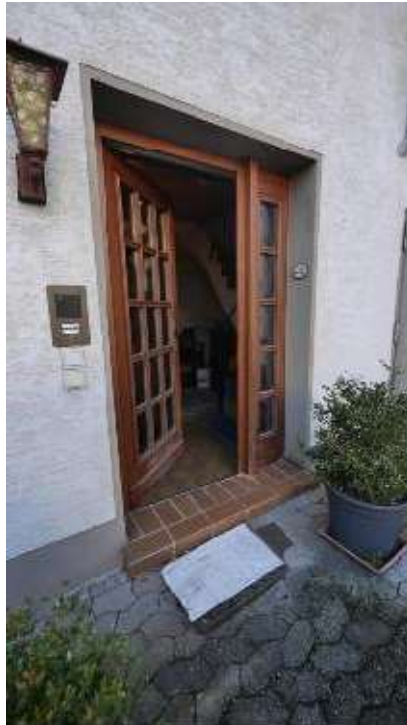
Bild B14 Eingang ehemalige Scheune
