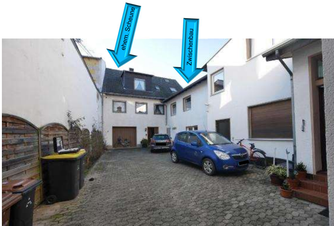
Bild B4 Hofansicht - Blick auf Zwischenbau und ehemalige Scheune
