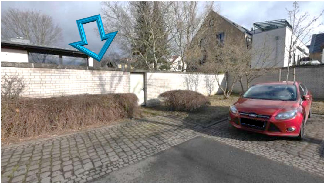
Bild B12 Blick von Südwesten (Parkplatz) in Richtung Bewertungsobjekt
