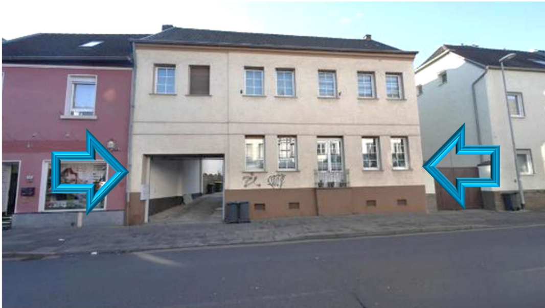
Bild B2 Straßenansicht
