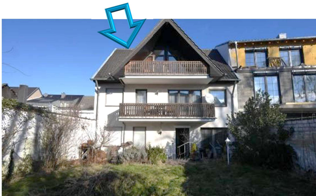
Bild B7 Rückansicht ehemalige Scheune
