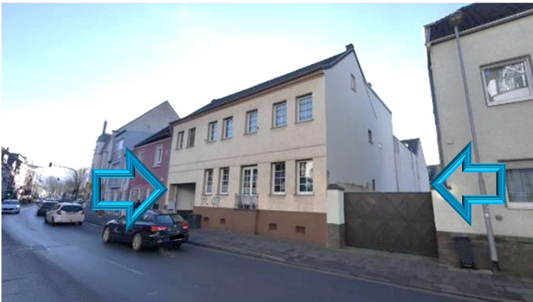
Bild B1 Straßenansicht
