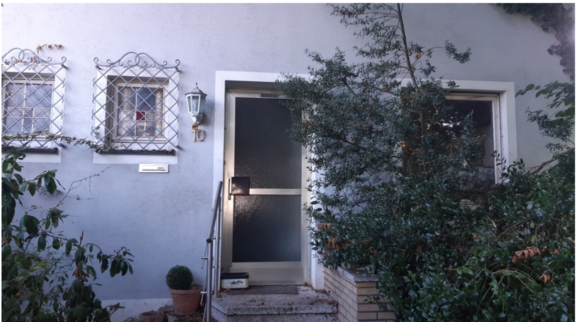
Nordansicht (Eingang) des Reihenendhauses
