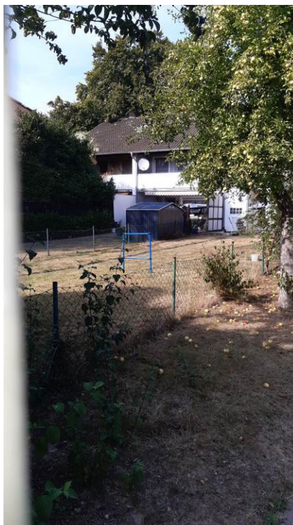
Südostansicht (Rückansicht) des Reihenendhauses
