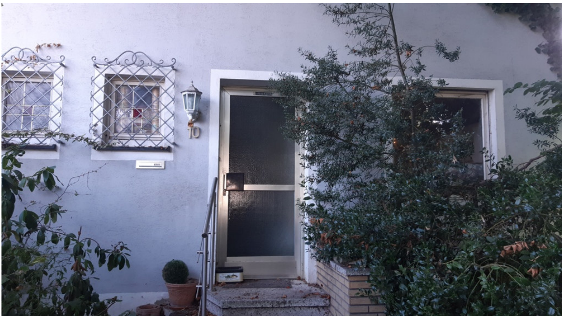
Nordansicht (Eingang) des Reihenendhauses
