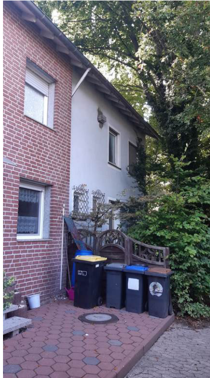
Ostansicht (Straßenansicht) des Reihenendhauses
