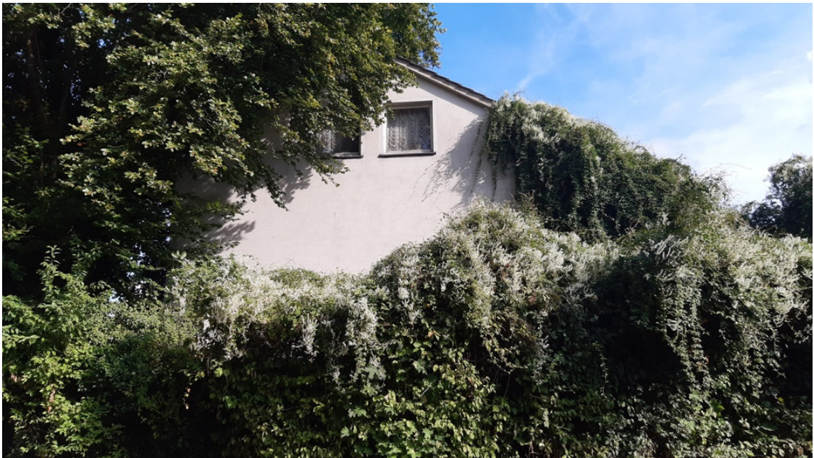
Nordwestansicht (Seitenansicht) des Reihenendhauses
