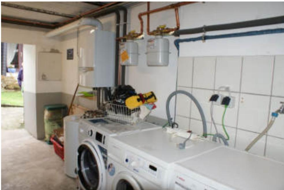
Bild 23 Gasheizung und Warmwasserboiler für das EG
