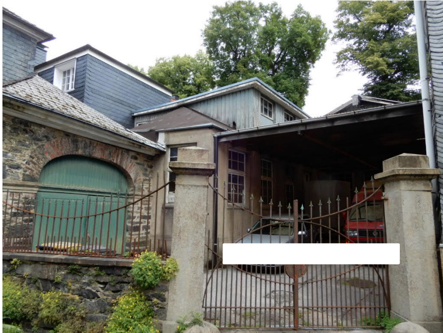
Zufahrt zu Garage und Schreinerei/Hofüberdachung
