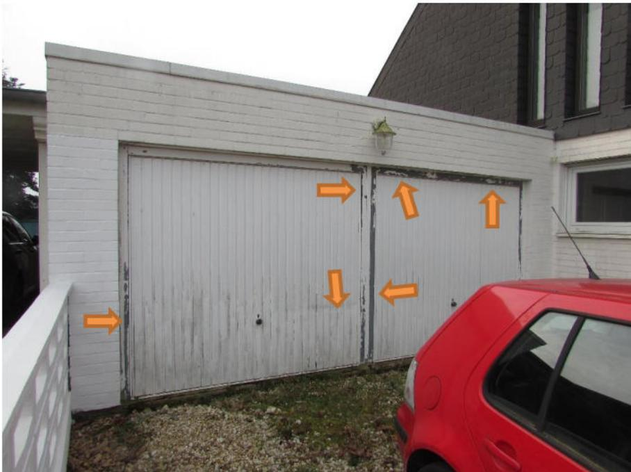
Foto 10: PKW-Doppelgarage, abgeplatzter Anstrich der Metallschwingtore, korrodierte Metalleinfassung
