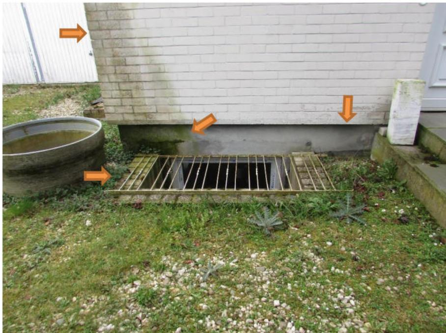
Foto 8: Wohnhaus, Feuchtigkeit im Sockelbereich, fleckige Fassade, provisorische Abdeckung des Kellerlichtschachts
