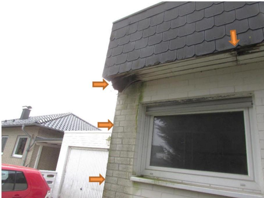
Foto 7: Wohnhaus, fleckige Fassade, stark beschädigte Holzverkleidung
