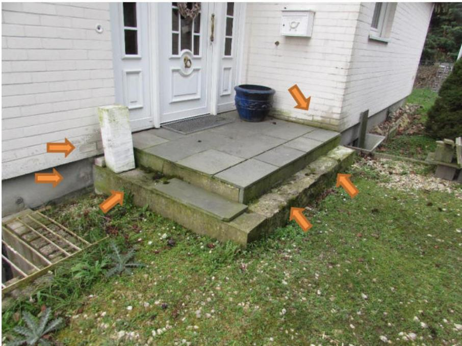
Foto 6: Wohnhaus, Hauseingang, beschädigte Hauseingangstreppe, Feuchtigkeit im Sockelbereich, fleckige Fassade
