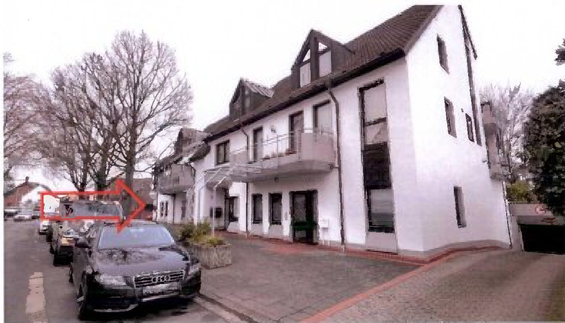
Bild 4: Blick in die Erschließungsstraße Klosterstraße -Ausfahrt Tiefgarage
