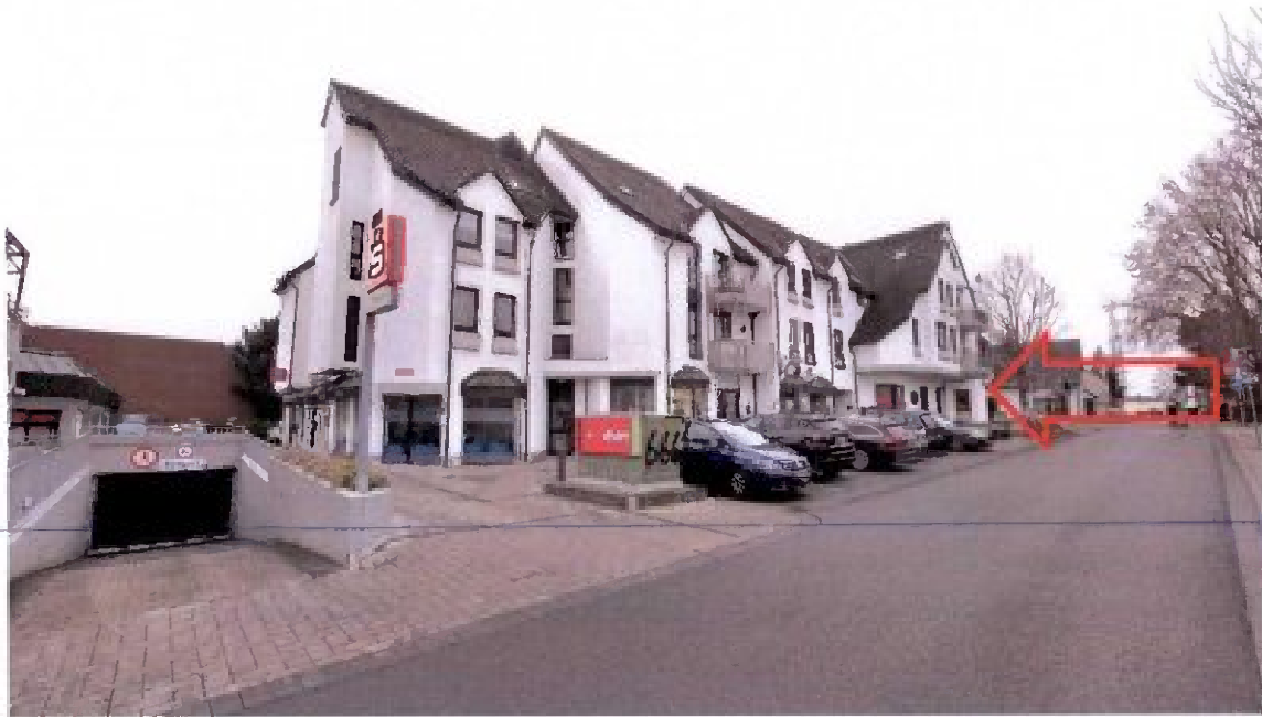
Bild 3: Blick in die Erschließungsstraße Glockengasse
