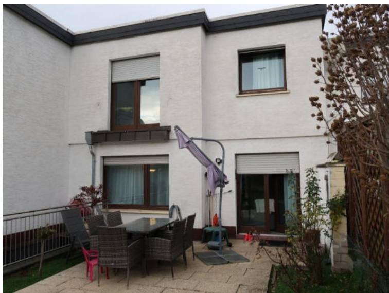
Bild 3 Außenansicht Einfamilienhaus Gartenseite
