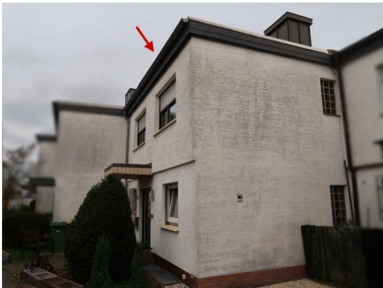
Bild 2 Außenansicht Einfamilienhaus (Flurstück Nr. 294)
