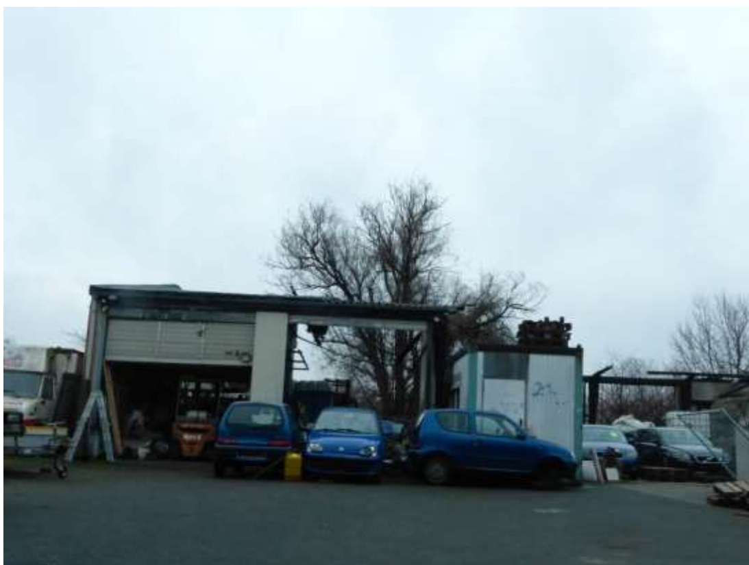
Ansicht Südost der abgebrannten Halle- wesentlicher Bestandteil des Flurstücks 133:
