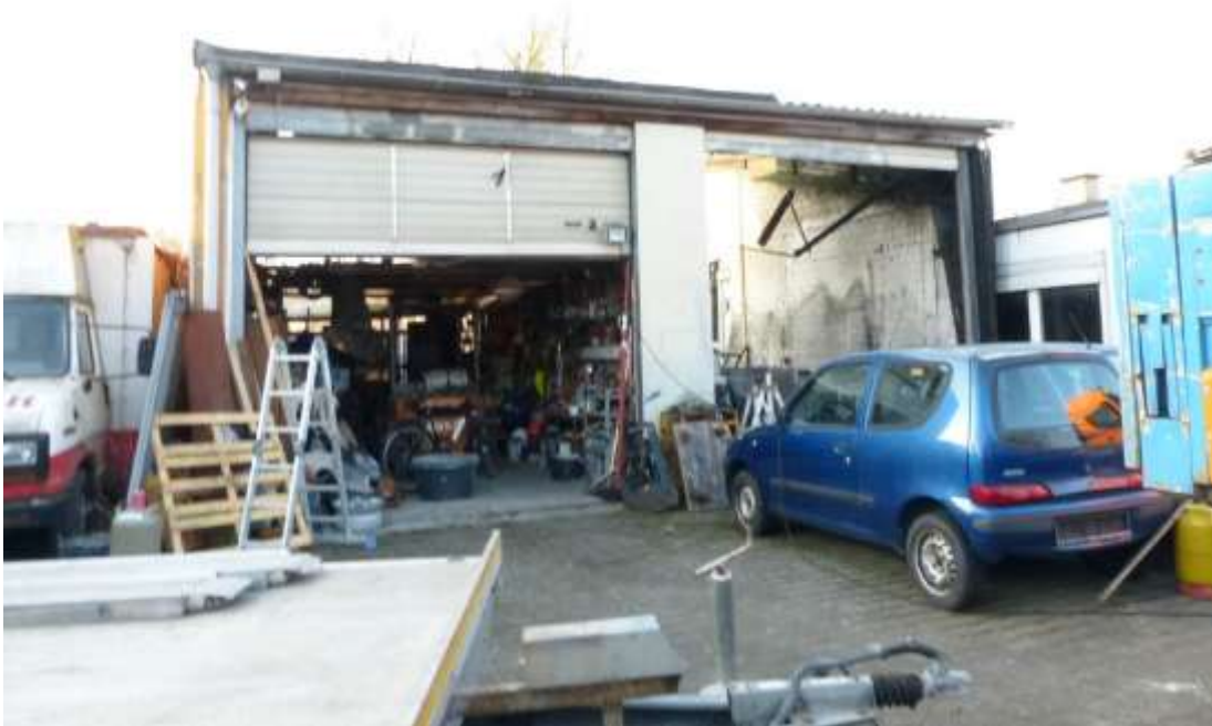
Teilansicht Südost der abgebrannten Halle - wesentlicher Bestandteil des Flurstücks 133
