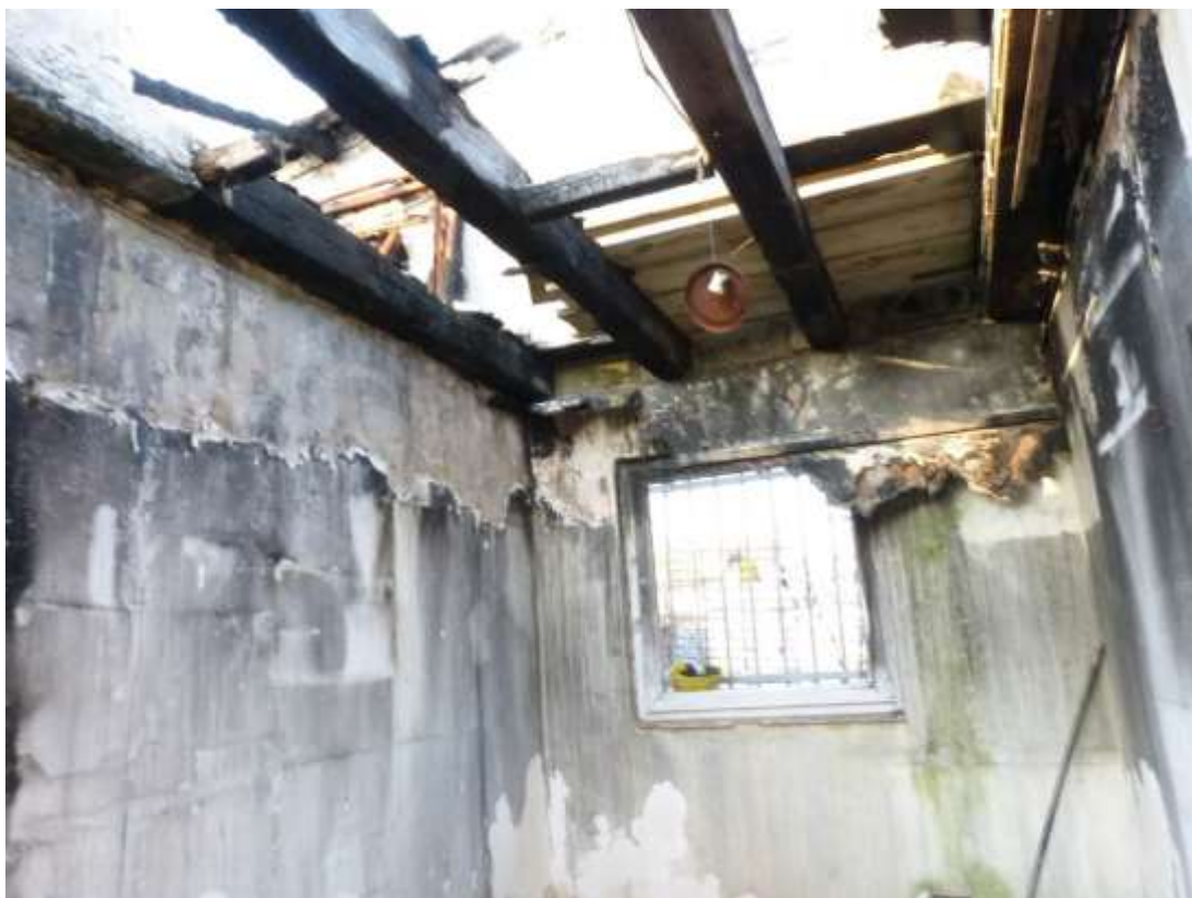
Decke über den Büro- und Sozialräumen
