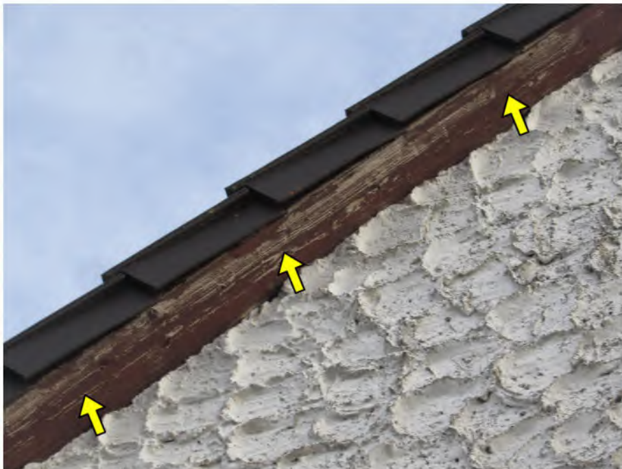
Foto 8: verwitterter Ortgangsparren
