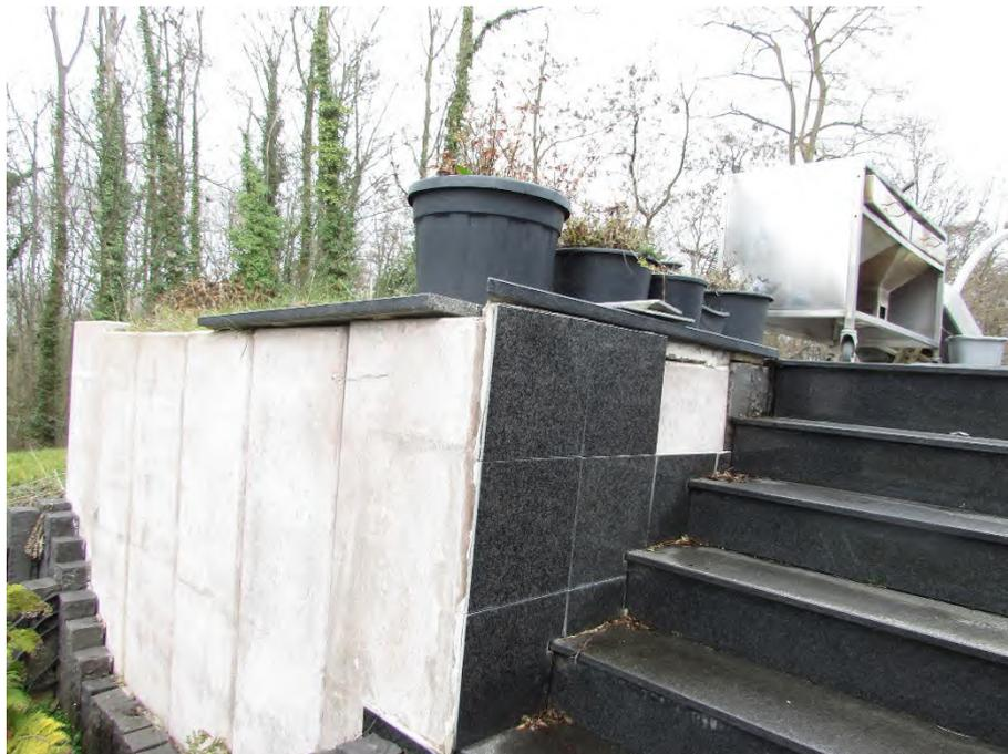
Foto 12: Stützwand der Terrasse: abgeplatzte Granitverblendung
