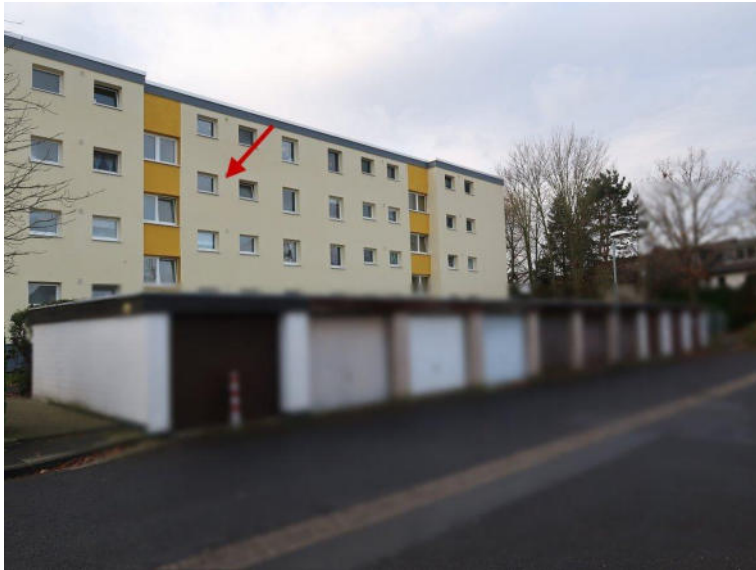
Bild 1 Außenansicht WET Nr. 10
