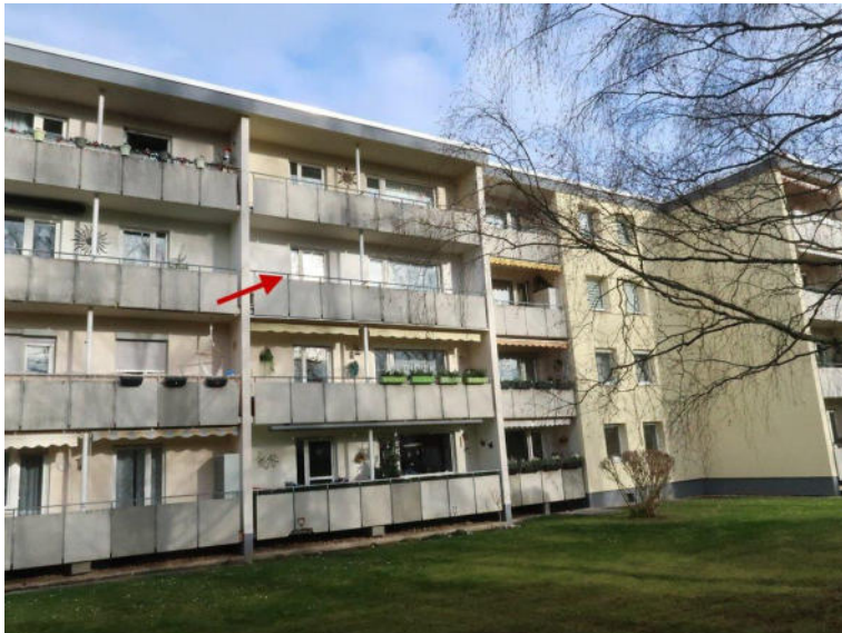
Bild 2 Außenansicht WET Nr. 10
