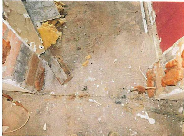
Bild 18: Obergeschoss - Zimmer - Riss Estrich
