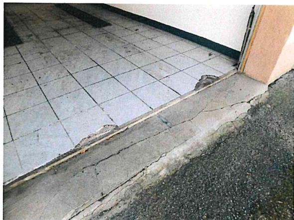
Bild 40: Garage - Fliesen z.T. stark beschädigt, Estrich Ro
