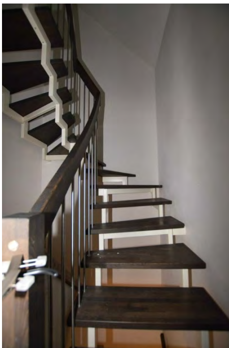
Treppe zum Spitzboden
