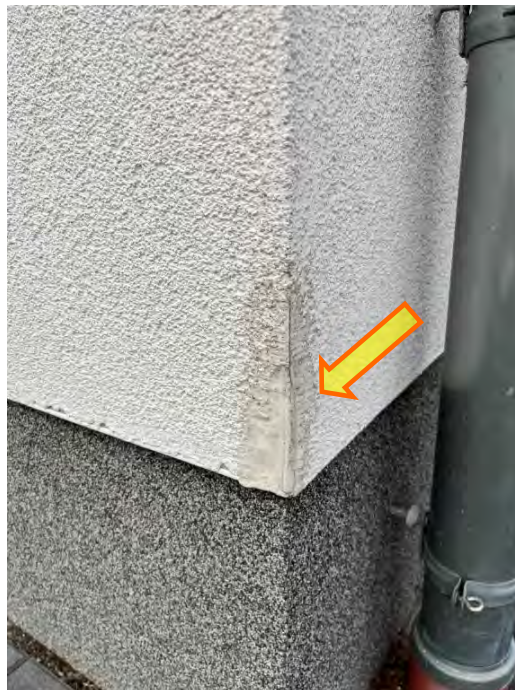
Außenputzschäden (Beispiel)
